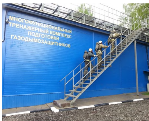
Рис. 1. Подъём на кровлю комплекса
