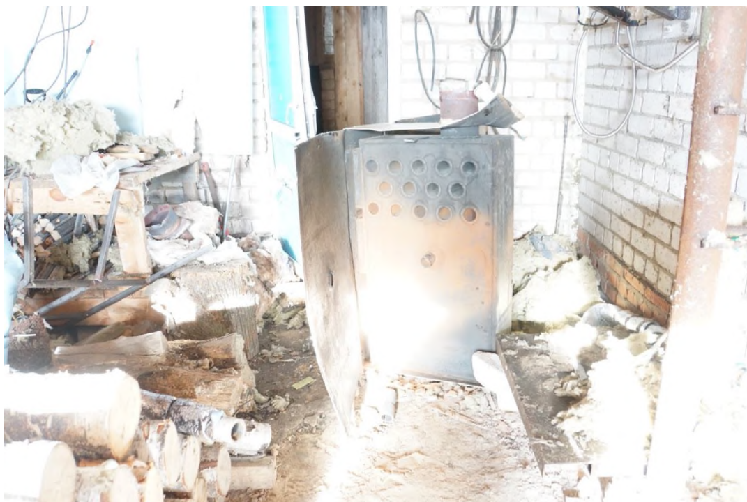
Рисунок. Разрушения отопительного котла на твердом топливе
