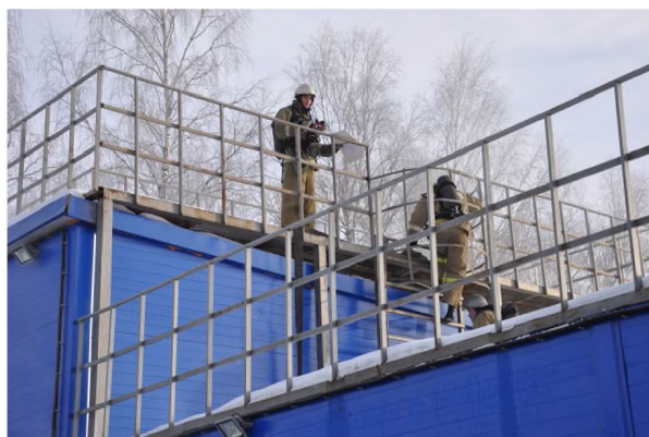
Рис. 5. Спуск к люку, имитирующий вход в помещение
